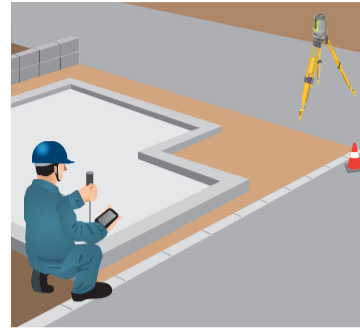
● 基礎出来形確認に
